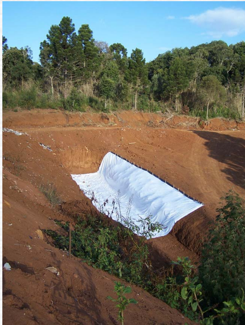
Ampliação do Aterro Sanitário Gal.Carneiro - 05/06
