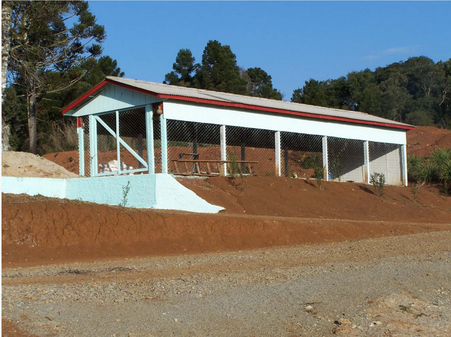
Vala séptica RSS – Gal.Carneiro - PR – 04/06
