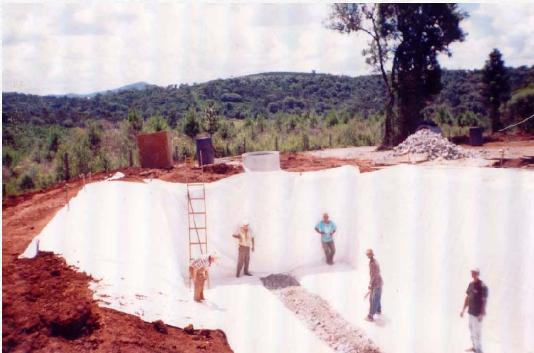
Aterro sanitário de rejeitos - Gal.Carneiro – PR 01/04
